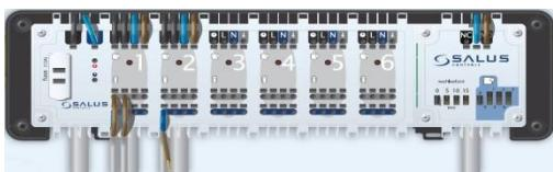
Ďalším krokom je vloženie vodičov do príslušných otvorov podľa schém zapojenia, ktoré sa nachádza v ďalšej časti návodu.
