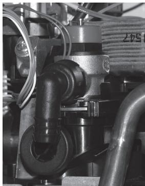
**Upozornenie:** V žiadnom prípade sa nesmie manipulovať s poistným ventilom počas prevádzky kotla. Ďalej nie je prípustné využívať poistný ventil na vypúšťanie vody z kotla alebo vykurovacieho systému. Na ventil zanesený nečistotami z vykurovacieho systému sa nevzťahuje záruka.
